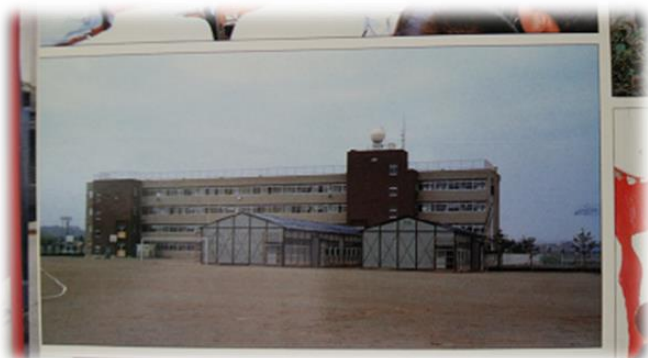
開校当時の教室棟とプレハブ校舎 (第1期生の卒業アルバムより)
